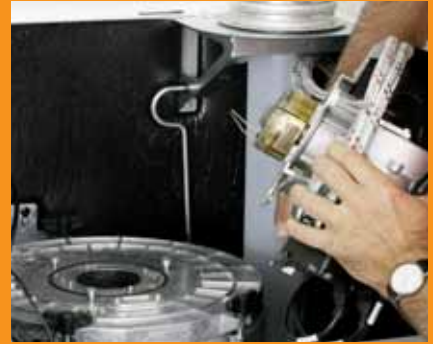
Retirez l'unité de combustion
