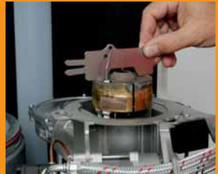
Contrôlez les électrodes d'allumage
