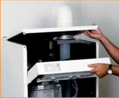
Ouvrez l'habillage et rabaissez le tableau de régulation
