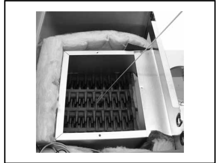
Bild: Reinigung Rauchgaszüge
