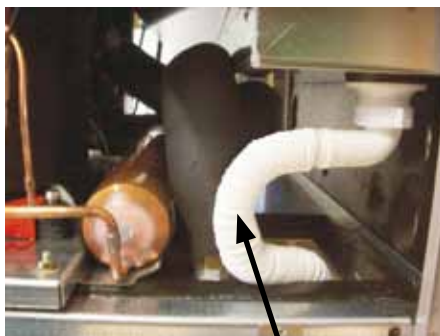
Kondensatablauf mit stetigem Gefälle verlegt
