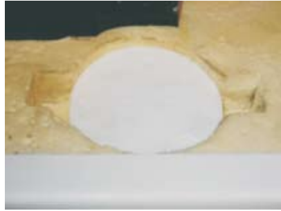
Isolatie dekseel boven offeranode verwijderen
