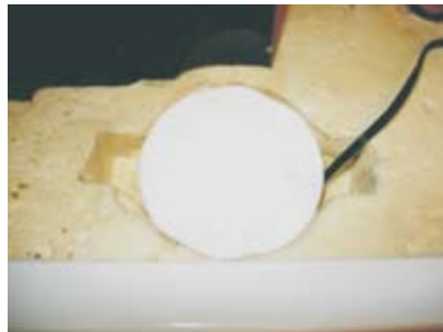
Aansluitingen afsluiten met isolatie dekseel.
