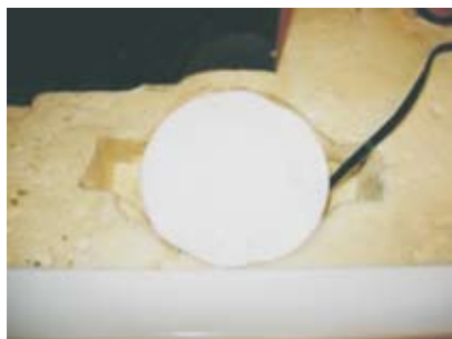
Monter isoleringen over anoden igen.
