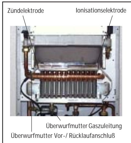
Bild: Brenneinheit ausbauen
