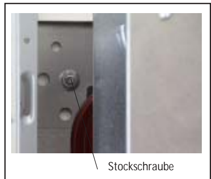
Bild: Gastherme montieren mit Stockschrauben
