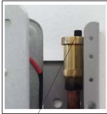
Bild: Entlüfterschraube am Schnellentlüfter
