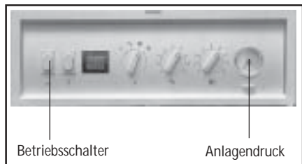
Bild: Gesamtansicht Regelung
