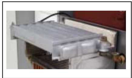
Bild: Demontage Heizwasserwärmetauscher
