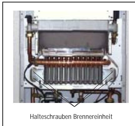
Bild: Brenneinheit ausbauen
