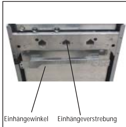
Bild: Gastherme in Einhängewinkel einhängen
