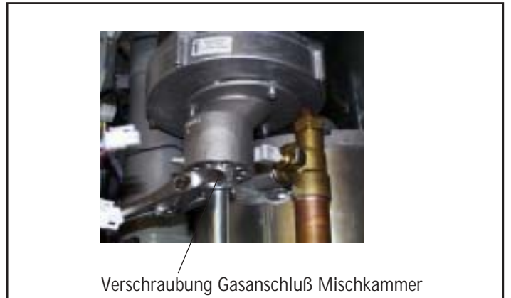
Bild: Verschraubung Gasanschluß Mischkammer
