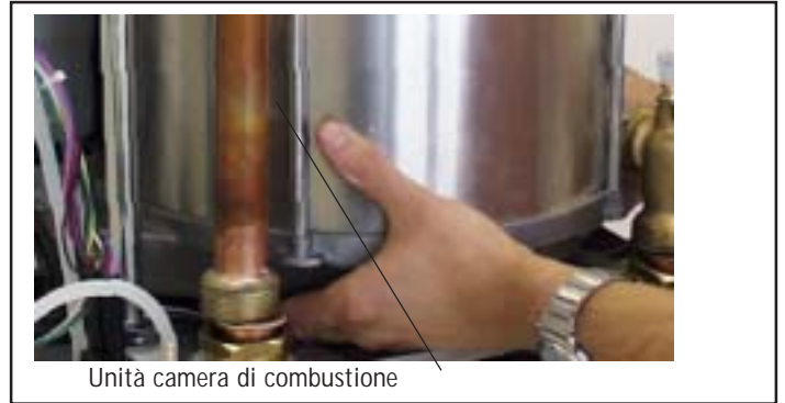
Figura: Unità camera di combustione
