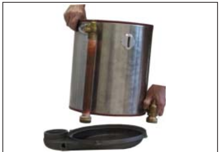
Figura: Estrarre lo scambiatore primario verso l'alto
