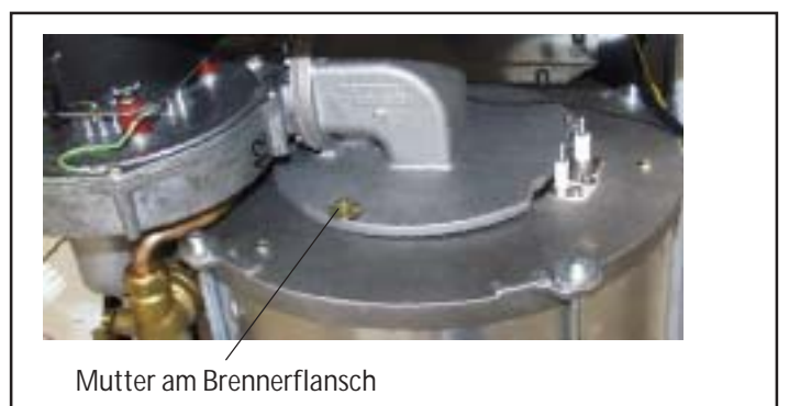
Bild: Mutter am Brennerflansch
