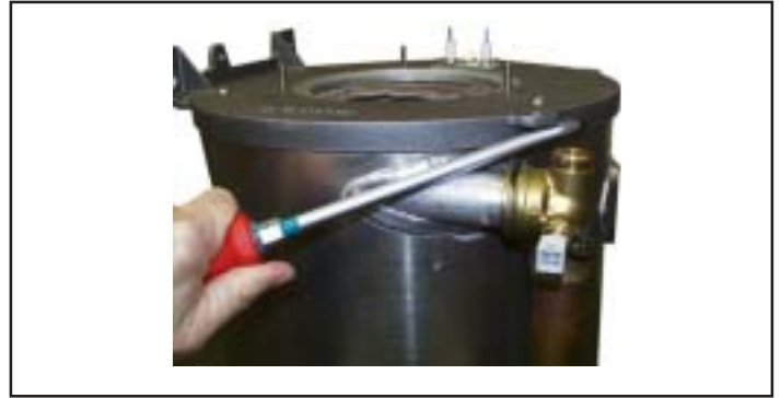
Figura: Togliere il coperchio dalla camera di combustione
