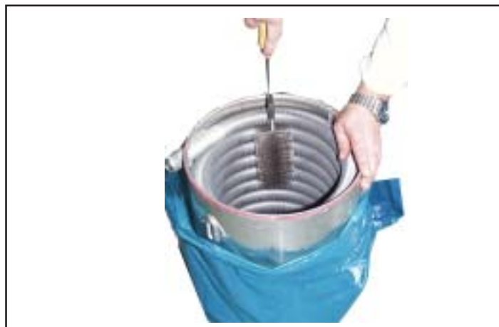
Figura: Pulizia dallo scambiatore primario
