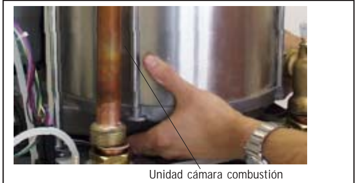
Fig: Unidad completa cámara de combustión
