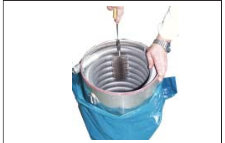
Bild: Wärmetauscher reinigen
