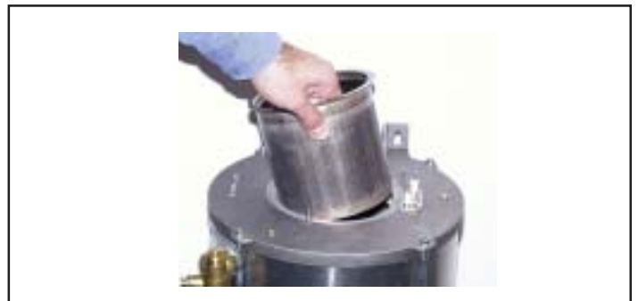
Bild: Brenner nach oben herausnehmen
