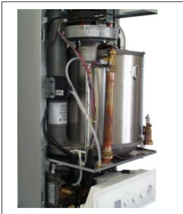
Figura: posizionamento linee di comando pneumatiche
