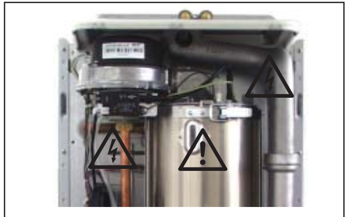
Bild: Zündtrafo, Hochspannungs-Zünder, Brennkammer Gefahr durch elektrische Spannung, Gefahr von Verbrennung durch heiße Bauteile
