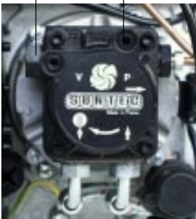
Druckmeßanschluß
