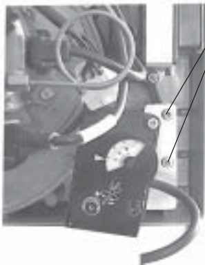
Befestigungsschrauben Luftklappenstellmotor
