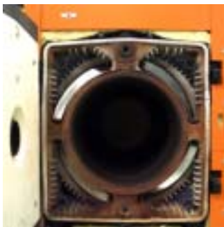
Gesamtansicht mit Turbulatoren eingelegt
