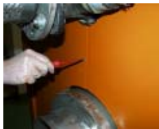
Verschraubung der Verkleidungsbleche zueinander
