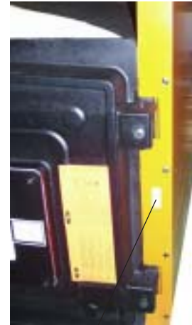
Öffnung für Brennerkabeldurchführung
