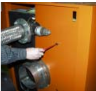
Verschraubung der hinteren Verkleidungsbleche ans Hinterglied
