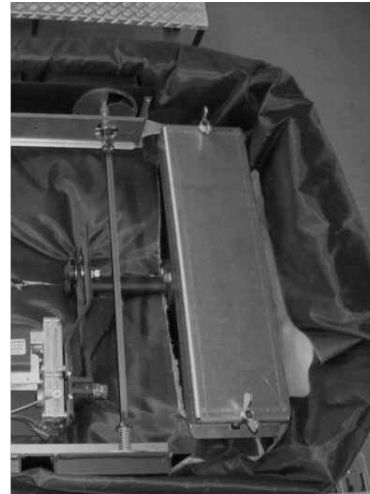
Verschlusschrauben lösen, Reinigungsdeckel (12) entfernen und die Halterung der Turbulatoren lösen.
