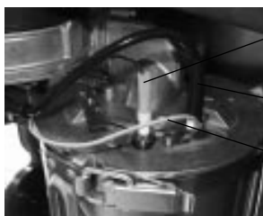
Ionisations- kabel Zündleitung Masseleitung
