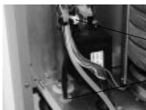
Zug- entlastung Dichtungs- manschette geschlitzt
