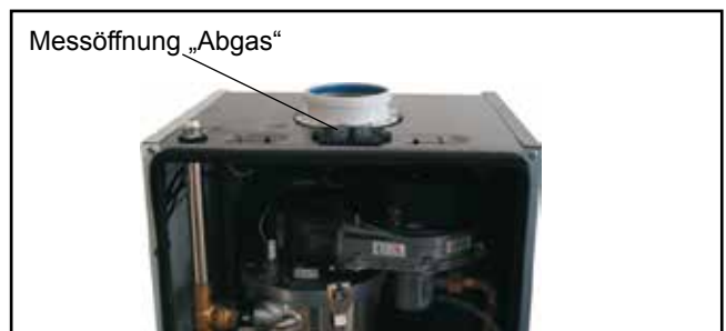
Bild: Abgasmessung bei geöffnetem Gerät
