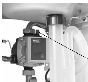
odvzdušnění výstup zásobníku
