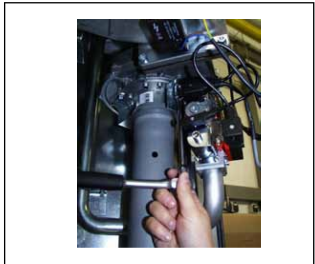
Bild: Schrauben zwischen Gebläse und Mischkammer lösen
