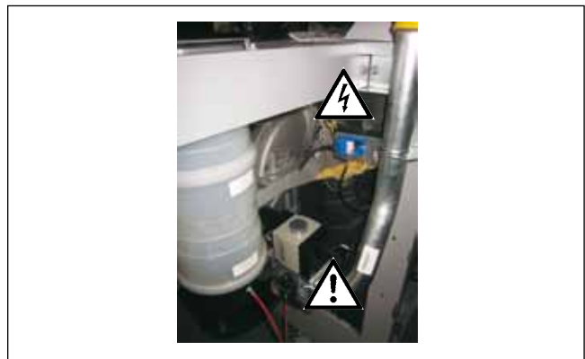
Bild: Zündtrafo, Hochspannungs-Zündelectrode, Gaskombiventil, Gasdruckwächter, Ventilator, Brennkammer Gefahr durch elektrische Spannung, Gefahr von Vergiftung und Explosion durch ausströmendes Gas, Gefahr von Verbrennung durch heiße Bauteile.
