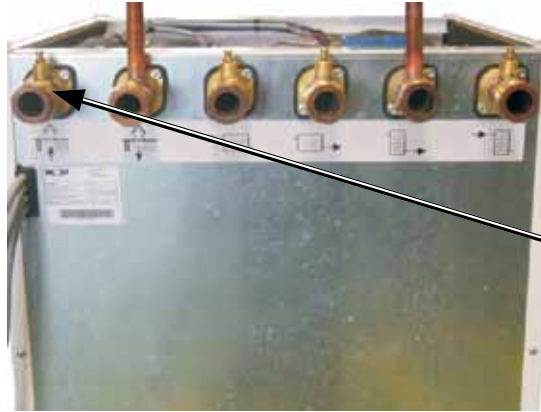
Handentlüfter im Sole-Eintritt
